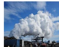
IDDP-1の噴気試験の様子 (坑口状態で) 温度450℃・圧力14MPa 出力30MW相当
