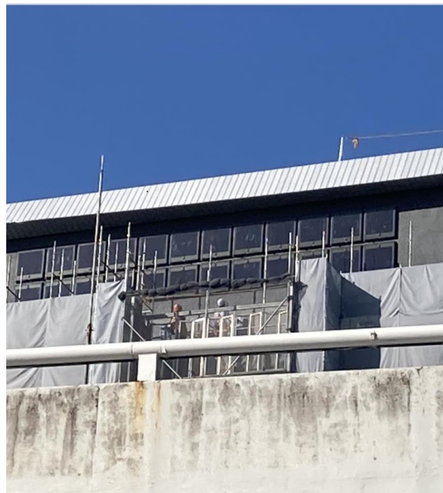
建物壁面への実装工事の様子
