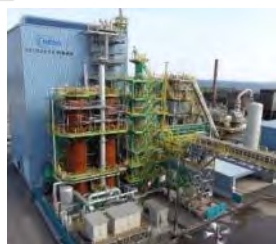
12m 3 小規模試験高炉(水素還元)
