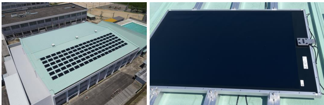
体育館屋根へのペロブスカイト太陽電池の設置（提供：滋賀県）
