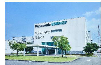
パナソニックエナジー住之江工場 (出所) パナソニックエナジー
