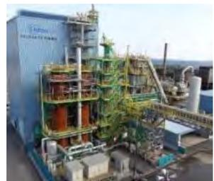
12m³ 小規模試験高炉(水素還元)
