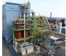
12m 3 小規模試験高炉(水素還元)
