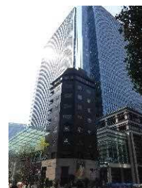
災害時用 飲料水/雑用水供給設備 室町東三井ビルディング(COREDO室町)様
