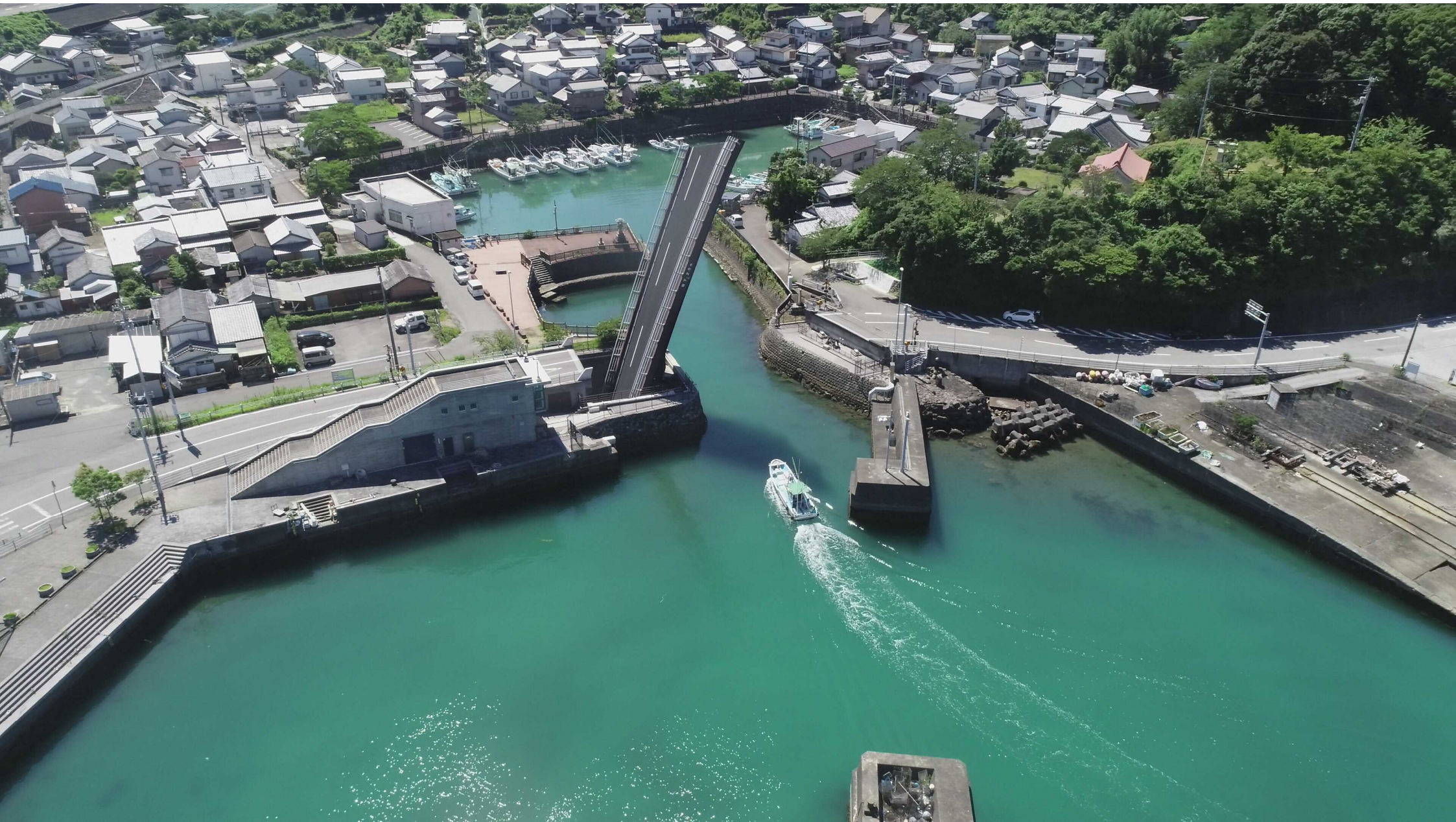
手結港（可動橋）
