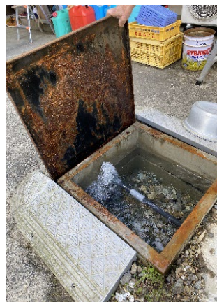
写真2 深井戸（自噴井）
