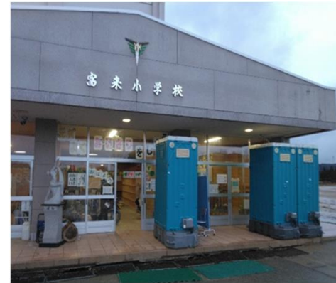
仮設トイレの設置
