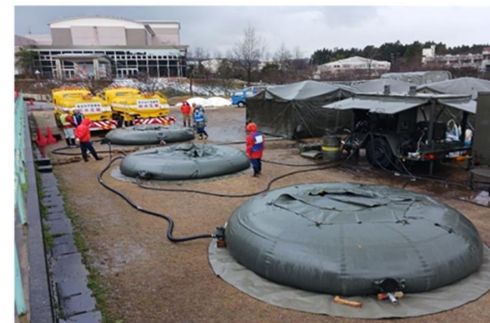
▲仮設風呂への給水活動
