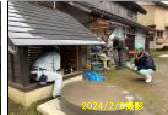
揚水試験実施状況
