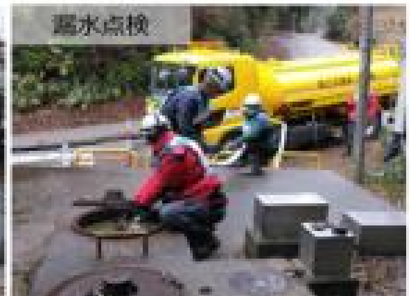
漏水点検 輪島市清土ポンプ場 配水管漏水調査
