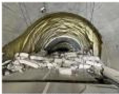
国道249号大谷トンネル（珠洲市）
