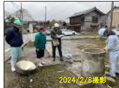
既設井戸現地調査状況
