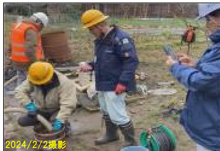
既設井戸における揚水試験状況
