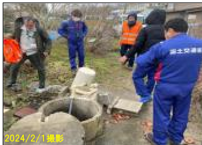
既設井戸現地調査状況
