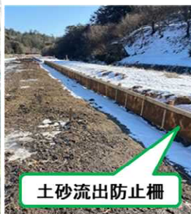
土砂流出防止柵設置状況
