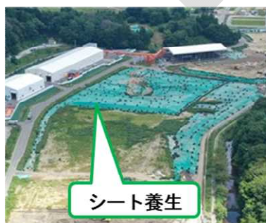
シート養生状況
