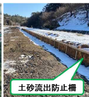
土砂流出防止柵設置状況
