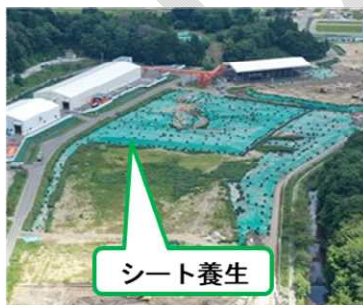
シート養生状況
