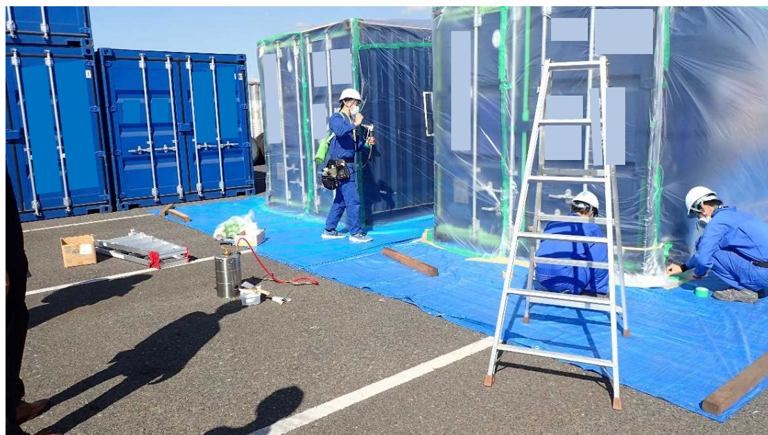
当該コンテナの熏蒸作業
