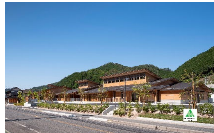
公共木造建築物の例
