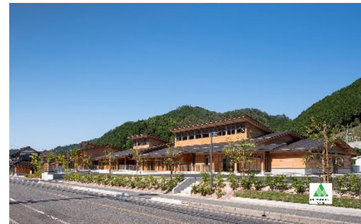
公共木造建築物の例
