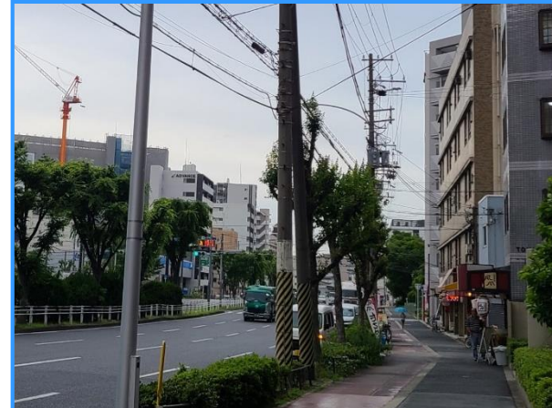
無電柱化（緊急交通路）
