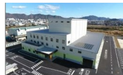
容器包装リサイクル推進施設
