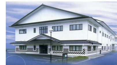
汚泥再生処理センター
