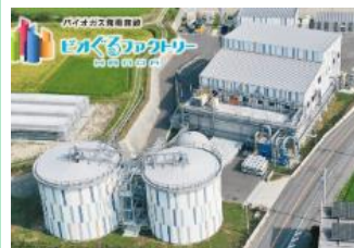
バイオガスプラント
