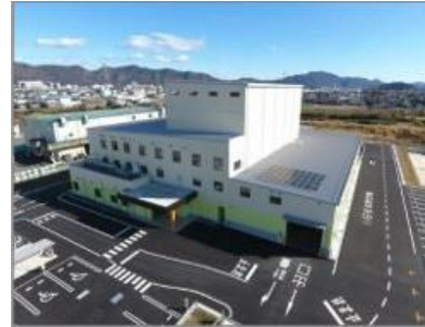
容器包装リサイクル推進施設
