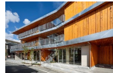
写真@坂下智広 集成材とCLTを使用した 都市型木造集合住宅
