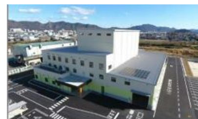
容器包装リサイクル推進施設
