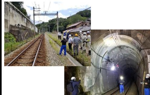
老朽化が進んでいる鉄道構造物の維持管理コストの低減と作業員の安全確保のため、ドローンを用いた目視検査や、赤外線カメラによるコンクリート構造物の「浮き」の検出を実用化に向け実施。
