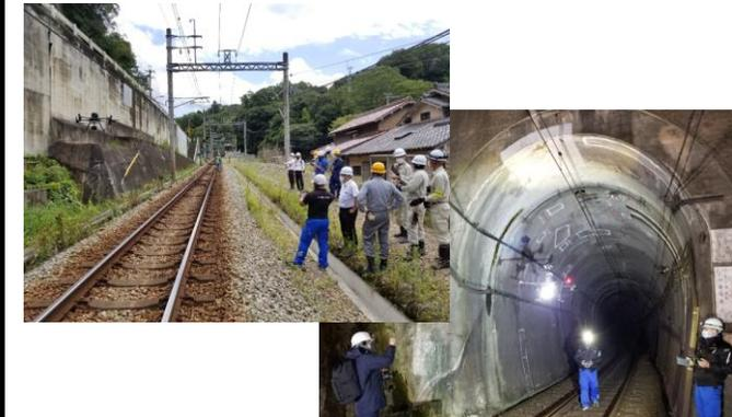
老朽化が進んでいる鉄道構造物の維持管理コストの低減と作業員の安全確保のため、ドローンを用いた目視検査や、赤外線カメラによるコンクリート構造物の「浮き」の検出を実用化に向け実施。
