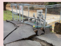
水道の復旧 (被災した浄水場)
