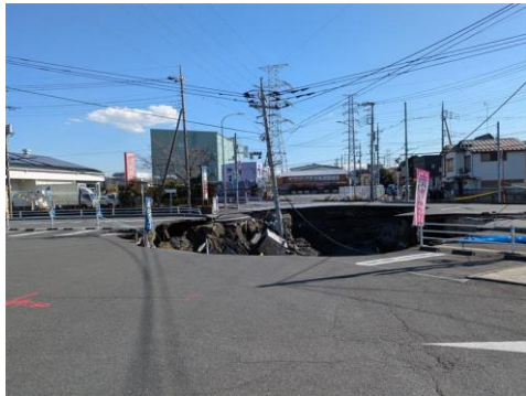
（インフラ） 埼玉県八潮市の県道交差点で発生した道路陥没事故
