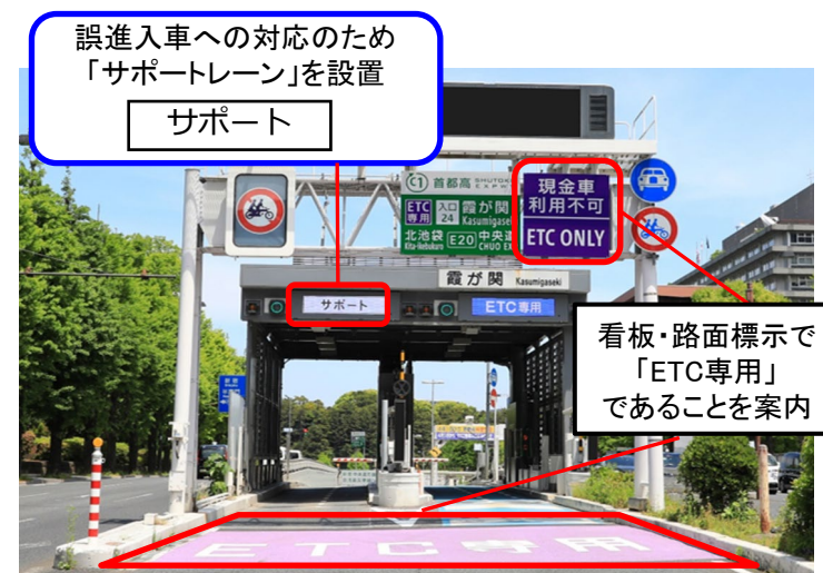
ETC専用化した首都高速道路都心環状線霞が関(外回り)入口
