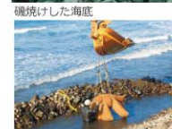
鉄分供給資材の敷設
