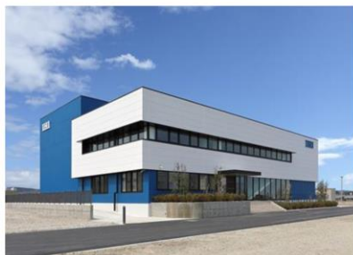
CO 2 フリー水素活用 水素研究棟「そうまラボ」
