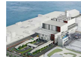
ごみ発電 (1焼却工場の建替え)
