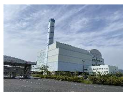
ごみ発電 (3焼却工場)
