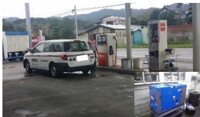
自家発電機を稼働させて、給油を続けたSS（千葉県鴨川市）
