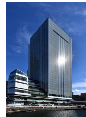
横浜市新市庁舎
