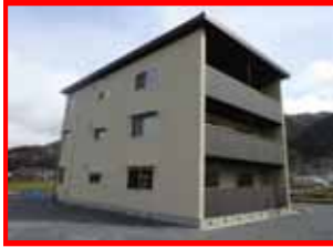
真庭市 集合住宅 (H27.3竣工) 岡山県真庭市 3階建て・1棟
