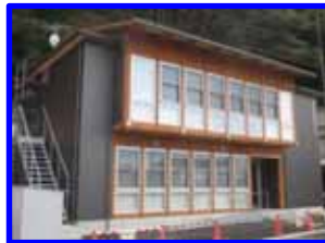
窪津漁業協同組合 事務所 (H28.1竣工) 高知県土佐清水市 2階建て・1棟
