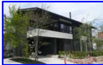
阿部建設(株) 住宅展示場 (H28.3竣工) 愛知県名古屋 2階建て・1棟
