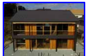
U邸 住宅 (H27.12竣工) 三重県伊勢市 2階建て・1棟
