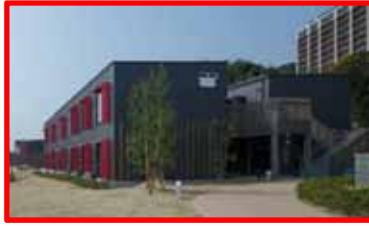
ハウステンボス ホテル (H28.2竣工) 長崎県佐世保市 2階建て・6棟
