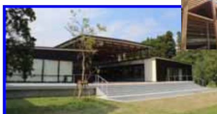
宮崎大学 交流会館 (H26.9竣工) 宮崎県宮崎市 1階建て・1棟
