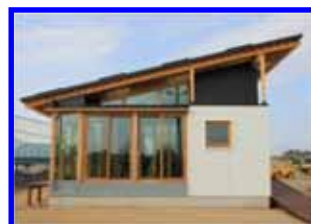
芝浦工業大学 実験施設 (H26.9竣工) 福島県会津若松市 1階建て・1棟
