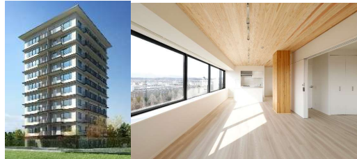
CLTを用いた10階建て共同住宅
