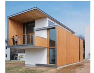
CLT工法による実験棟
