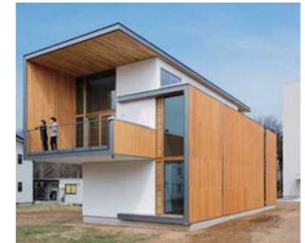
CLT工法による実験棟
