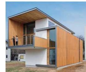
CLT工法による実験棟
