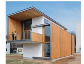
CLT工法による実験棟
