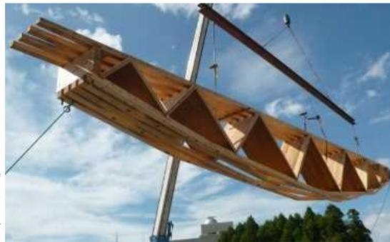
写真1 組立梁を吊り上げる様子
