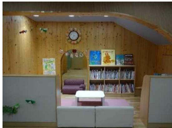
写真3 曲線にカットされたCLT
