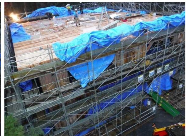
写真8 野外棟の建設現場(CLT屋根施工)
