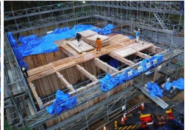
写真6 野外棟の建設現場(CLT 2階床施工)
