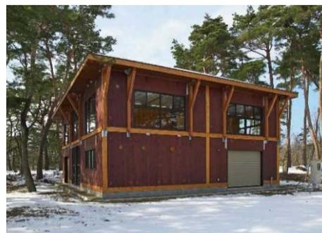
写真4 CLTパネル工法の建築
