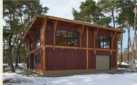
CLTパネル工法の建築（新潟県少年自然の家）
