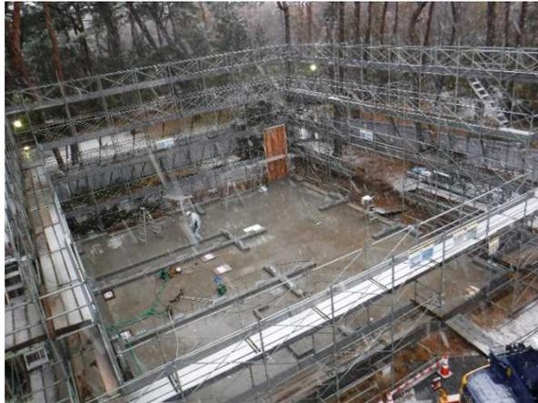
写真3 野外棟の建設現場(CLT施工開始)
