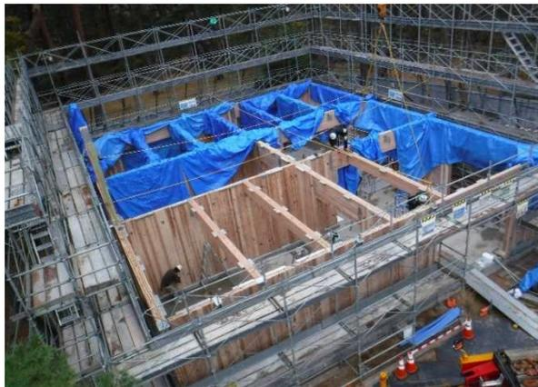
写真5 野外棟の建設現場(CLT 1階壁施工②)
