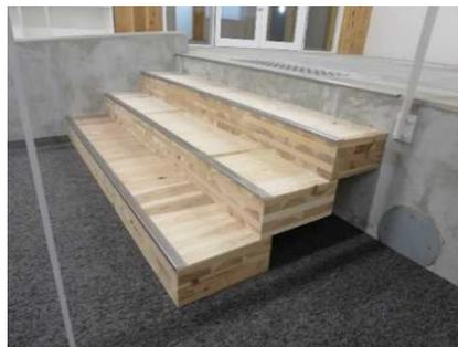
写真1 CLTの端材を活用した、側面が現しとなっている小階段
