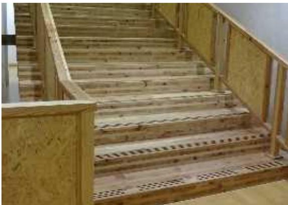
写真11 CLTの層部分が見える大階段
