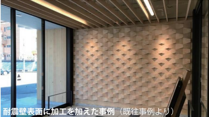
耐震壁表面に加工を加えた事例（既往事例より）
