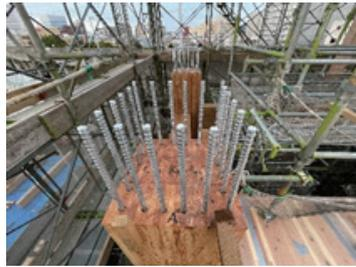
柱を GIR 接合により縦継ぎする
