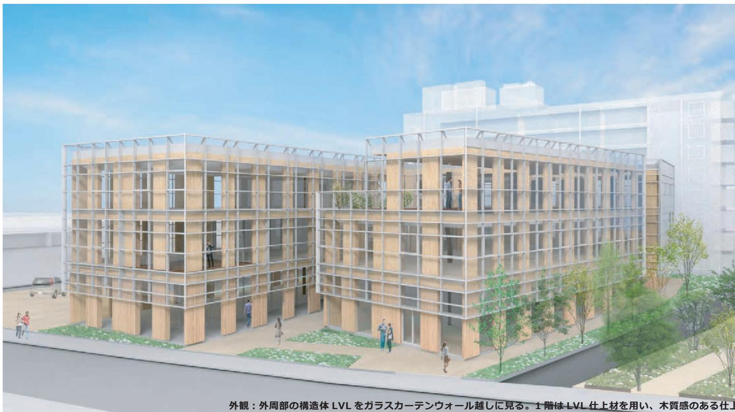
外観：外周部の構造体 LVL をガラスカーテンウォール越しに見る。1階は LVL 仕上材を用い、木質感のある仕上
