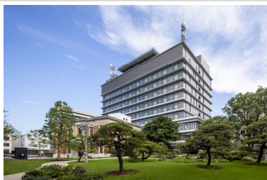
宮崎県防災庁舎 施工 戸田建設
