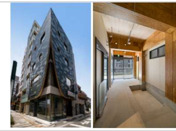
田園都市線 駒沢大学駅西口2ビル 施工 東急建設
