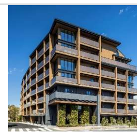
プランシエスタ 目黒中央町 設計施工 長谷工コーポレーション
