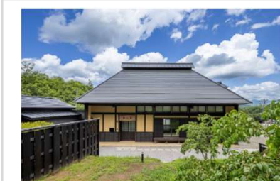
東急グループ慶太塾 設計施工 東急建設
