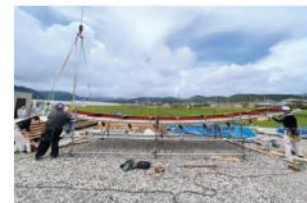
建て方 (CLT 曲面成型)
