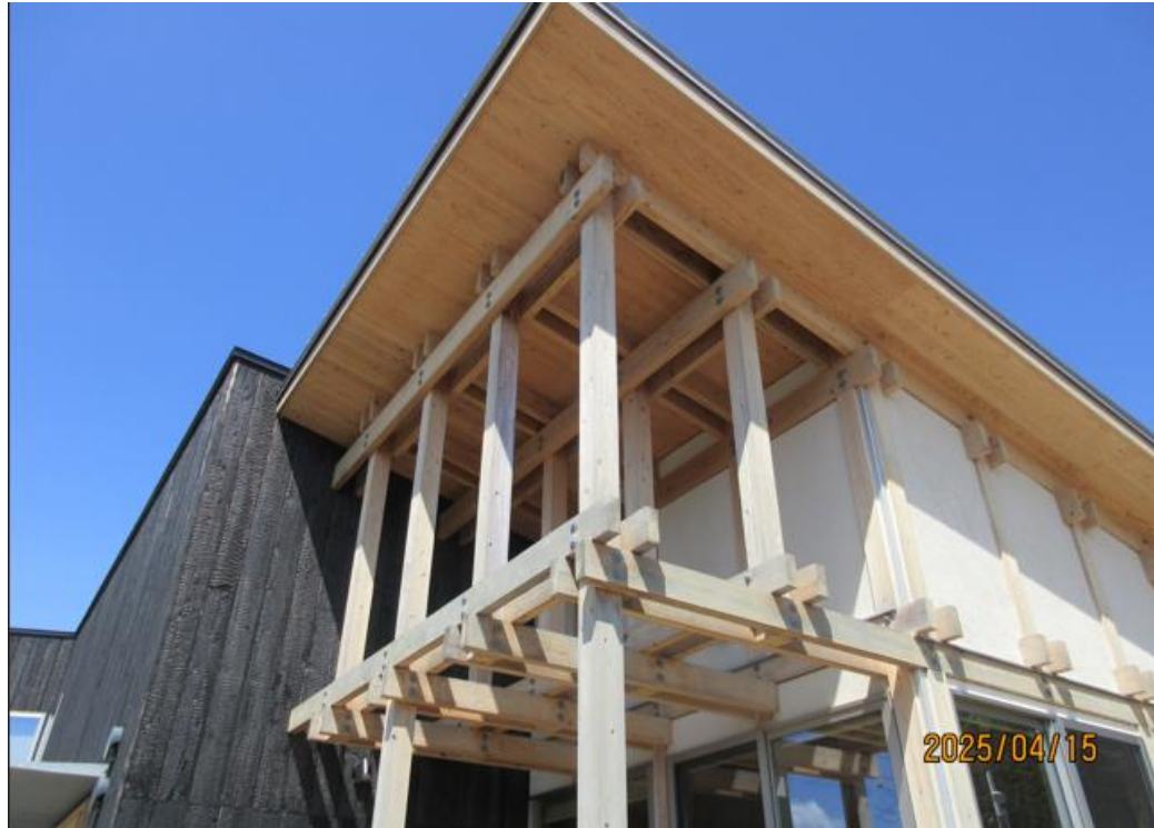
屋根下地にCLTを使用
