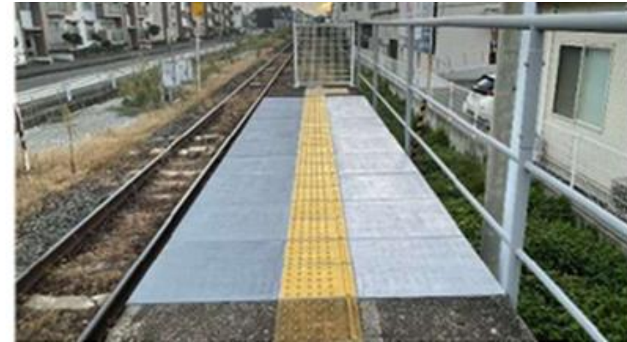
CLTプラットホームスラブ
