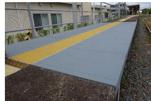
CLTプラットフォームスラブ (試験施工)
