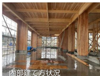
内部建て方状況
