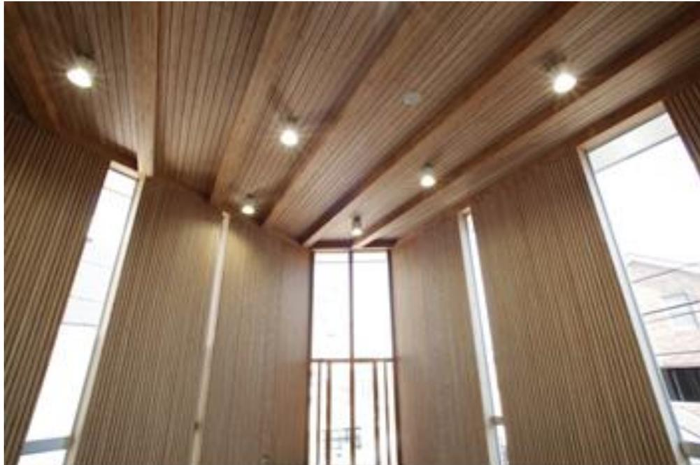
写真：軸組工法とパネルを用いた学校の事例
