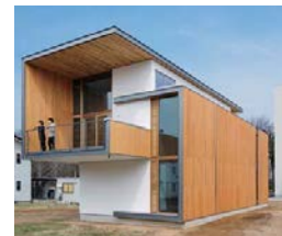
CLT工法による実験棟
