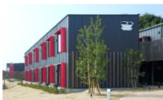
CLT工法による木造ホテル
