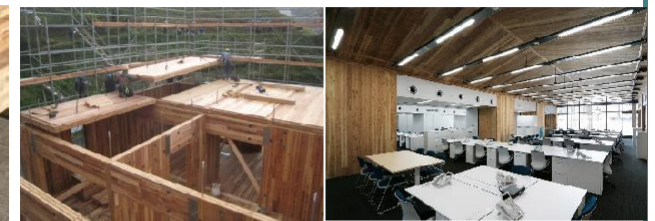
CLTを用いた施工例
