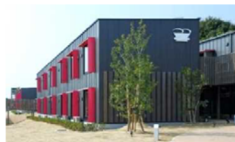
CLT工法による木造ホテル
