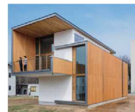
CLT工法による実験棟
