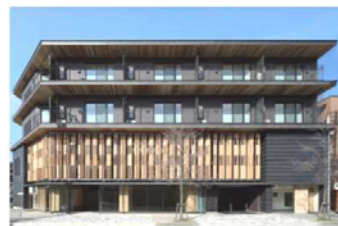
木質耐火部材を使用した耐火建築物
