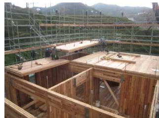
CLTを用いた施工例
