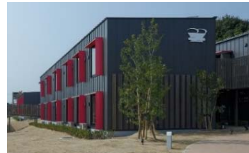
CLT工法による木造ホテル
