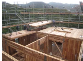
CLTを用いた施工例
