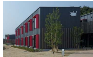
CLT工法による木造ホテル
