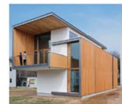
CLT工法による実験棟
