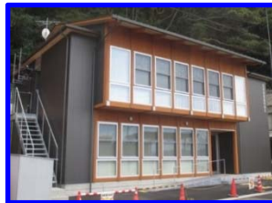
窪津漁業協同組合 事務所(H28.1竣工) 高知県土佐清水市 2階建て・1棟
