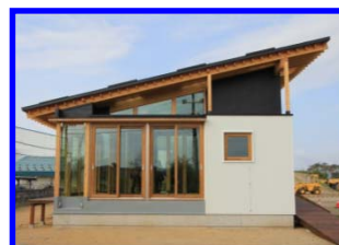
芝浦工業大学 実験施設(H26.9竣工) 福島県会津若松市 1階建て・1棟
