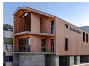
実証例:CLTの断熱性能を検証した事務所
