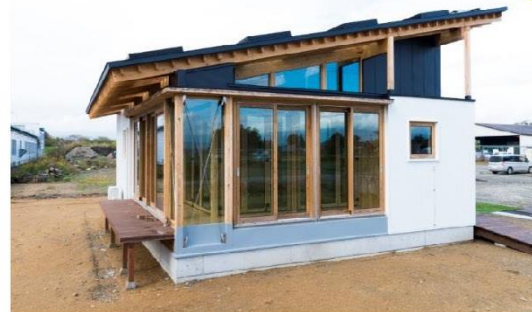
実証実験棟「母の家2030」 会津若松市に移設（写真提供：会津土建（株））
