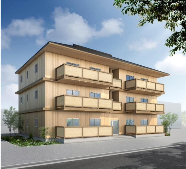
評価可能となるCLTパネル工法の住宅イメージ (耐震等級2・劣化対策等級3取得可能な設計の例) (一般社団法人日本CLT協会 提供)
